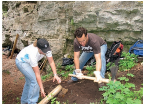
Steigsanierung zur Vermeidung von Erosionsschäden
